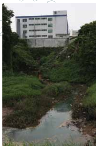
工业区外，隐藏在草丛中的排污管
