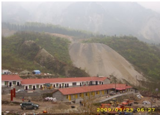
图 9 邓家火地矿段大明山 1# 矿渣堆现状图
