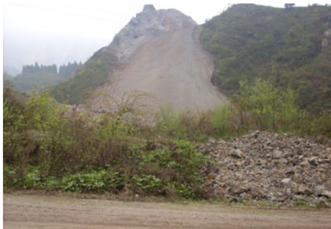
图 10 邓家火地矿段大明山 2# 矿渣堆现状图
